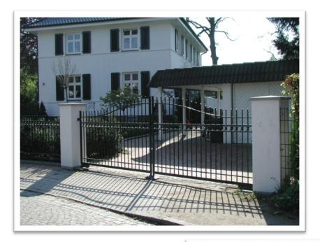
Anlage mit Unterflurantrieb und gemauerte Pfeiler
