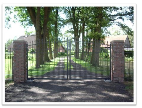
Komplette Anlage 2-Flg. mit Unterflur E-Antrieb pulverbeschichtet
