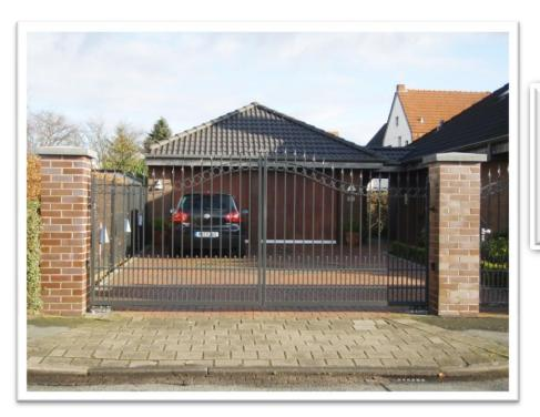
Ummauerte Torpfosten Unterflurantriebe Oberer Abschluss mit Zierspitzen
