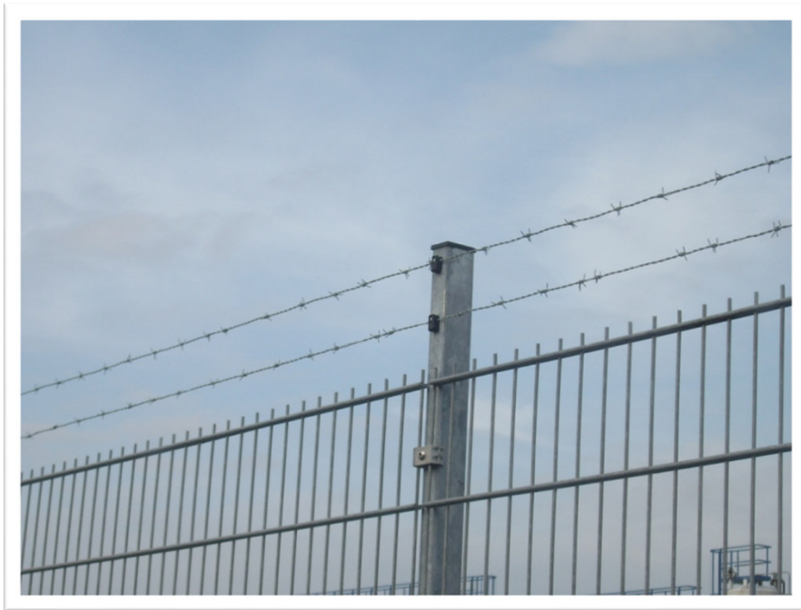
Längerer Gitterpfosten mit Haltern und 2 Reihen Stacheldraht
