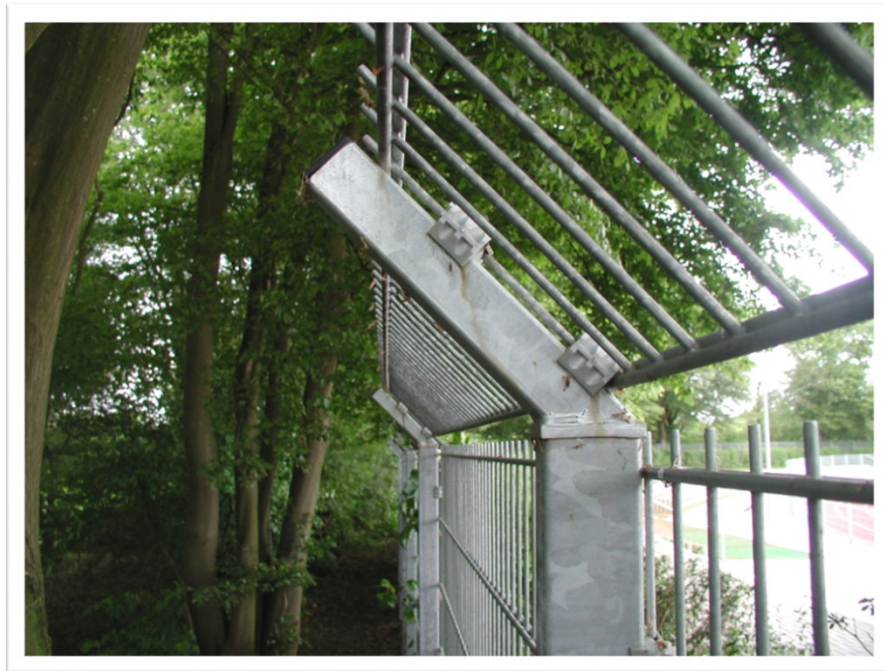
Übersteigschutz durch Doppelstabmatte mit abgewinkelte Halter
